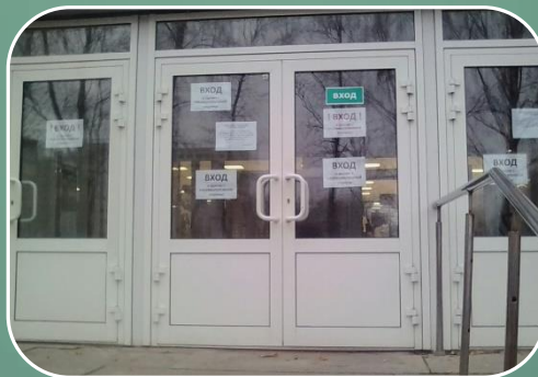
Вход (входы) в здание
